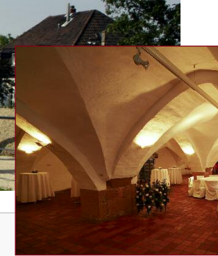
Das mächtige Kreuzgewölbe im Festungskeller stammt aus der frühesten Bauphase. Es bildet heute den eindrucksvollen Rahmen für viele private und öffentliche Veranstaltungen.
